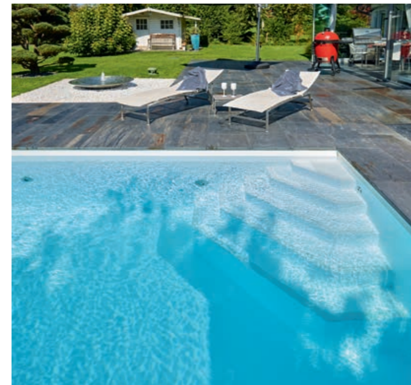
Bei dem Swimmingpool handelt es sich um ein Fertigbecken aus Hart-PVC von KWS. Die Treppe wurde als harmonische Ecklösung ausgeführt.
