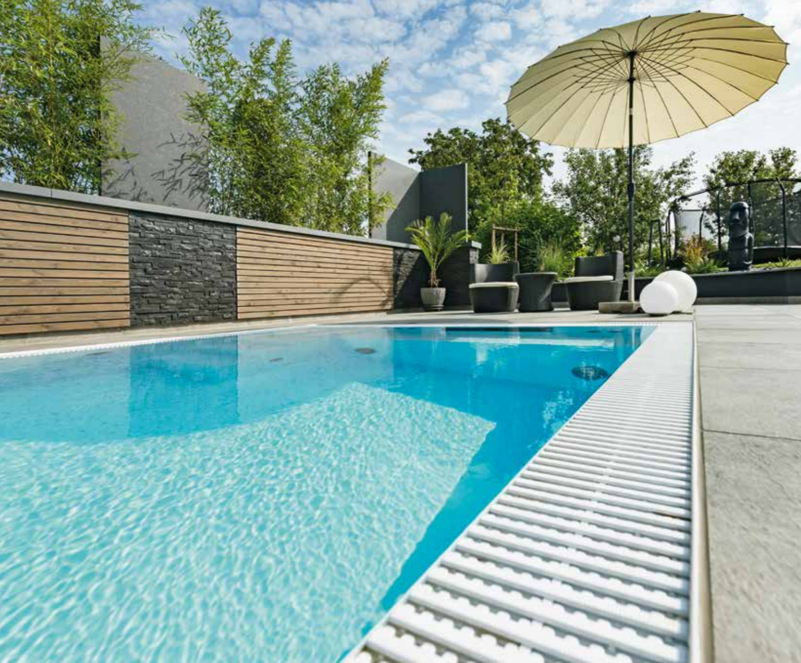
Der weiße Pool aus PP-Kunststoff mit Überlaufrinne wurde maßgeschneidert auf die Kundenwünsche angepasst – die Technik ist in einem Raum hinter der Natursteinwand untergebracht. Dieser Raum dient auch als Garage für die Überdachungselemente.
